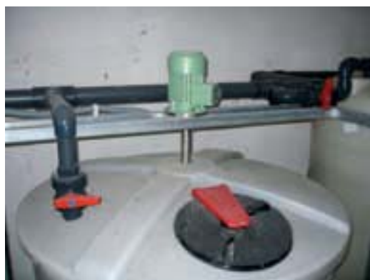
Fotografía 1.8: Sistemas de agitación mecánico (izquierda) y mediante aire (derecha).
