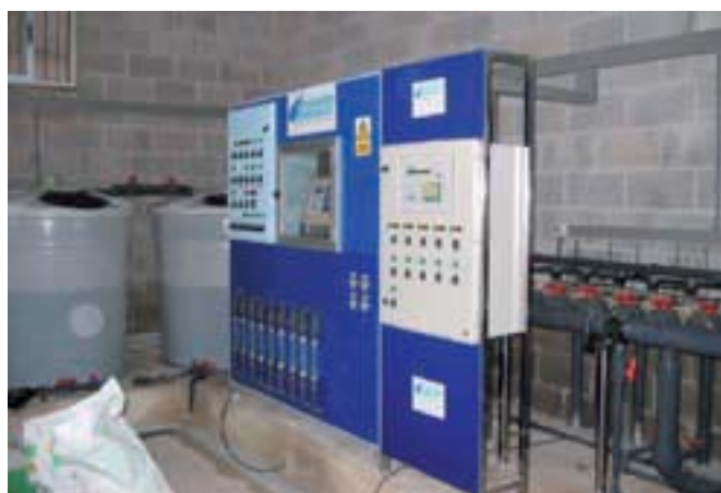
Fotografía 1.20: A la derecha programador de riego sencillo. A la izquierda moderno sistema de control del riego y la fertilización.
