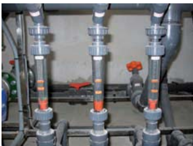
Fotografía 1.15: Instalación de rotámetros en un moderno equipo de fertirrigación.
